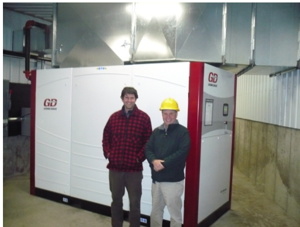
New 135 hp VSD air compressor
