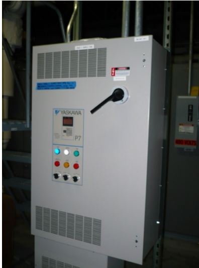
50 hp Supply Air Fan VFD
